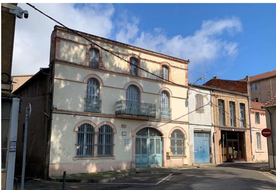
n°1 et n°3 rue du Château - façade donnant sur la place Charles Capéran
